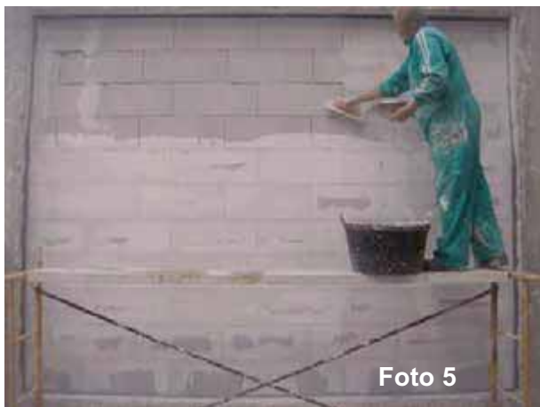
Fotos 5 y 6: Aplicación de revestimiento
