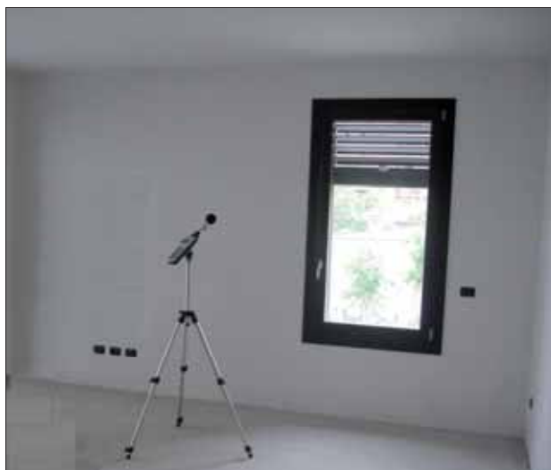
Fig. 8 – facciata esaminata, primo piano
