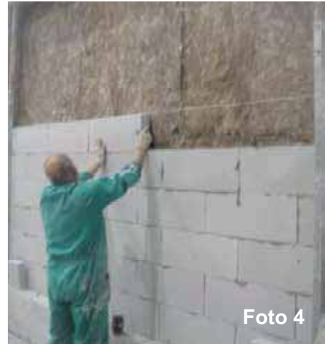
Fotos 3 y 4: Montaje de lana mineral y fábrica
