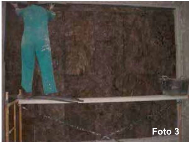
Fotos 3 y 4: Montaje de lana mineral y fábrica
